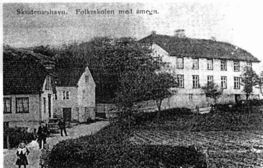
Det er i topp etasjen på denne gamle barneskolen at vi nå holder til. Alt i forgrunnen på dette bildet er borte. Det er bare skolebygget som kan gjenkjennes i dag,
